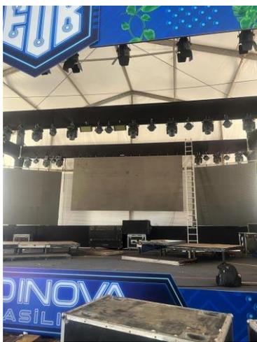
**3.15 - Estrutura de Alumínio Modular em Box Truss Tipo Q30 (Cumprido Integralmente);**
